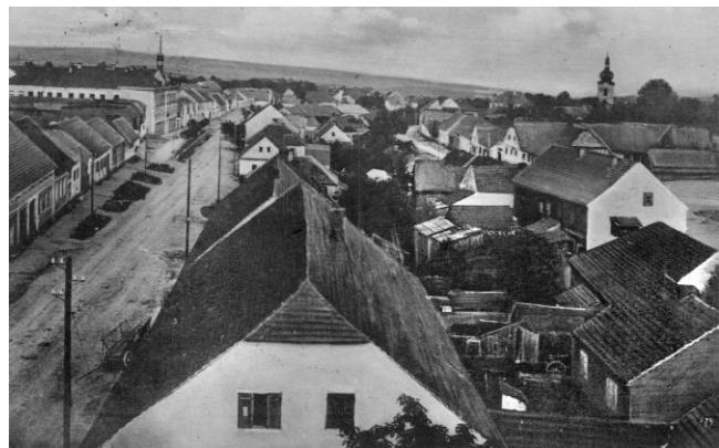
Pohled na hlavní ulici v roce 1924 s typickými dřevěnými sloupy krátce po zavedení elektřiny.
