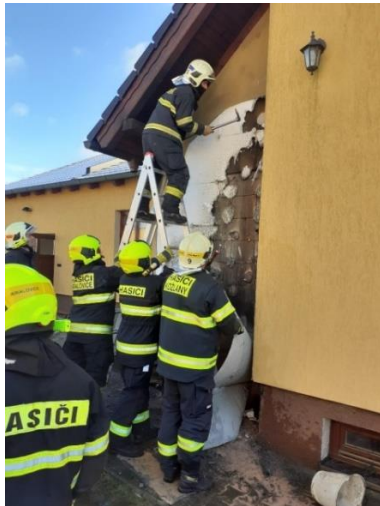
Provedli jsme dohazovací práce a museli jsme narušit fasádu k zabezpečení šíření ohně v zateplovacím
