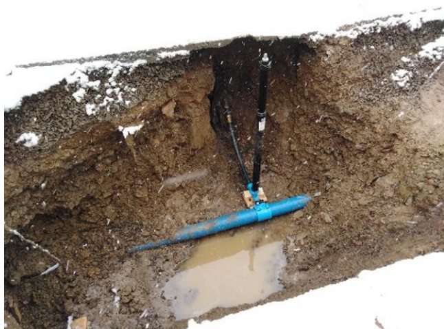
Oprava vodovodního řádu Kožlany
